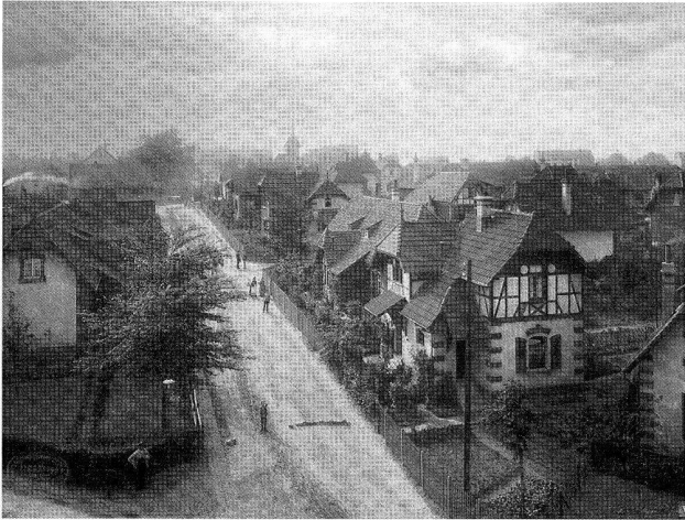
Die Kruppsche Wohnsiedlung Altenhof in Essen-Rüttenscheid, vor 1906.
