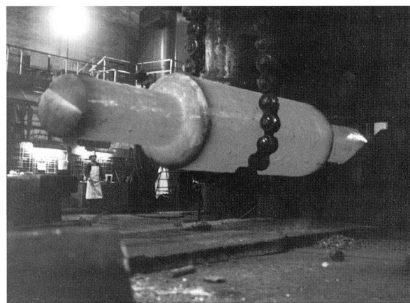
18 Stunden dauerte der Schmiedeprozess für die Generatorenwelle (Bildnachweis: privat).
