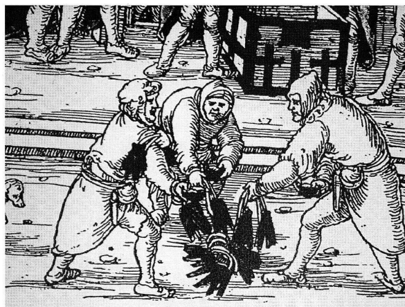
Abb. 6: Häuer beim Fassen der Bergeisen, ca. 1550 Lebertal. Ausschnitt aus Federzeichnung Nr. 10 von H. Gross, wie Abb. 5.
