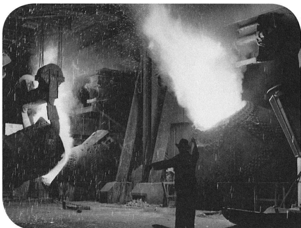
Die Stahlindustrie bot den Industriefilmern besonders spektakuläre Aufnahmen, wie hier im Thomasstahlwerk der August Thyssen-Hütte AG, wo ein blasender Konverter (rechts) zu sehen ist, während der zweite Konverter mit Roheisen gefüllt wird, Mitte der 1950er-Jahre (Fotograf: Herbert List, Quelle: ThyssenKrupp Konzernarchiv, Duisburg).
