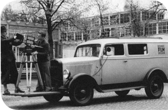
Um interessante Fahraufnahmen drehen zu können, konstruierte Boehner-Film Dresden eine spezielle Plattform, die vorne, an den Seiten und hinten an ihren Opel Blitz angebaud werden konnte (Archiv Fritz Lehmann).
