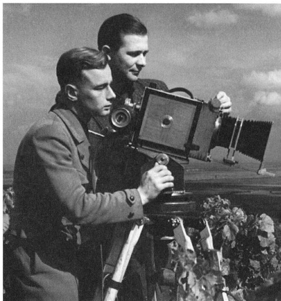
Kameramann Fritz Lehmann (li.) modifizierte für seine Arbeit bei Boehner-Film eine klassische Ernemann-Kamera mit Holzgehäuse und entwickelte daraus die EL-Berufs-Kamera. Durch das Kompendium waren Tricks wie Überblendungen usw. in der Kamera möglich (Archiv Fritz Lehmann).
