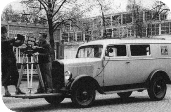
Um interessante Fahraufnahmen drehen zu können, konstruierte Boehner-Film Dresden eine spezielle Plattform, die vorne, an den Seiten und hinten an ihren Opel Blitz angebaut werden konnte (Archiv Fritz Lehmann).
