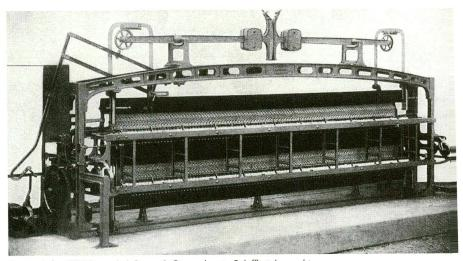
Die im Jahre 1867 von J. J. Rieter & Cie. gebaute Schifflistickmaschine (aus: Schweizer Pioniere der Technik, Rascher Verlag Zürich, 1944).
