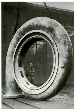
Spiralgehäuse aus Sulzer Stahlguss für eine der Hochdruck-Speicherpumpen der Zentrale Altendorf der Etzelwerk AG.
