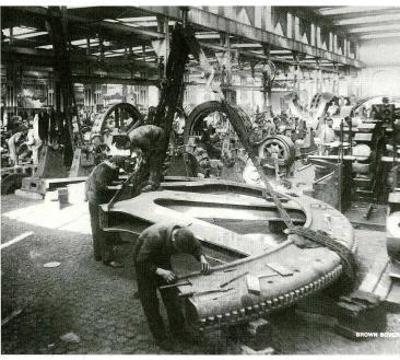
Bearbeitung eines Generator-Statorteils aus Grauguss bei BBC Baden, 1895.
