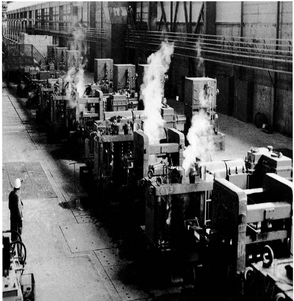
Kombinierte Stab- und Walzdraht-Strasse, 1980. Während der Stahlkrise 1975–1988 nahm das dreiarmlige Warmwalzwerk auf dem Littauerboden (Littau) seinen Betrieb auf. Mit 123 Mio. Franken stellte es die grösste Investition in der von Moos-Geschichte dar.
