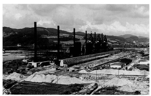
Abb. 5: Hochofenanlage der «Reichswerke» in Linz während des Baues, 18. Juni 1940. Die Hochöfen 1, 2 und 3 (rechts) sind weitgehend fertiggestellt, für Ofen 4 stehen die Cowper-Winderhitzer und der Abgaskamin, für Ofen 5 und 6 nur die Abgaskamine. (Beginn der Roheisenerzeugung am 15. Oktober 1941 mit Ofen 1). Bildarchiv Köstler.
