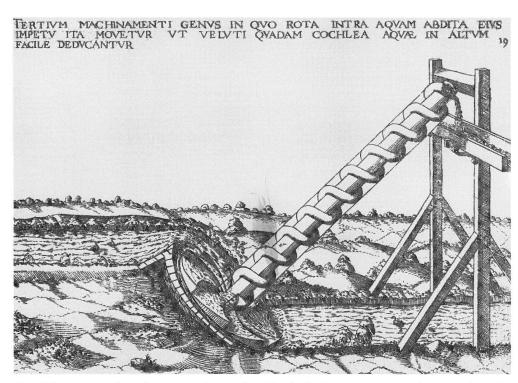
Abb. 3: Schematisierte Darstellung einer archimedischen Schraube für Bewässerungszwecke (Jean Errard, 1584).
