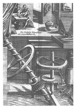
Abb. 8: Entwurf zum Antrieb einer Getreidemühle durch ein Perpetuum Mobile (Jacopo Strada) 1629).
