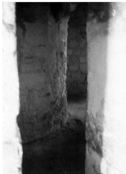
Observatorium «Caracol» Krümmung der inneren Gangmauer (Foto: Autor)
