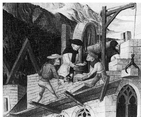
Abb. 2: Das Ideal der Mitarbeit von Mönchen im klösterlichen Bauhandwerk: Klosterbau durch den Hl. Bernhard (Detail). Tafel eines Flügelaltars, steirisch, 1518. Neuberg, Stiftskirche.
