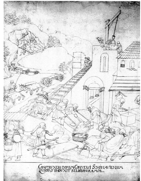
Baubetrieb der Zisterzienser: Laienbrüder errichteten das Kloster Schönau im Odenwald. Zeichnung nach älterer Vorlage, Ende 16. Jahrhundert (Nürnberg, Germanisches Nationalmuseum).
