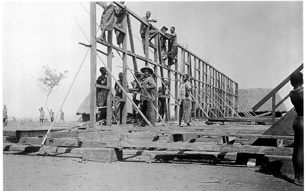
Abb. 5 (Sig. E-30.28.013) Copyright: Archiv der Basler Mission Bauten in der Hauptstadt eines afrikanischen Königs: Missionsbaumeister Eugen Schwarz leitet die Fachwerkkonstruktion des Missionshauses in der Hauptstadt von König Njoya. Der Vergleich mit Abb. 4 ist wichtig. Im Grunde genommen ähneln sich die zwei Bautechniken. Für den Missionsbau mussten zusätzlich zur einheimischen Technik Balken gesägt und die Geometrie und Technik des Zusammenfügens erlernt werden. Keine von den beiden bedeutet; eine grosse neue Abhängigkeit vom Westen. Einmal gelernt, konnten beide Innovationen mit minimalen fremden «Inputs» von afrikanischen Handwerkern eingesetzt werden.
