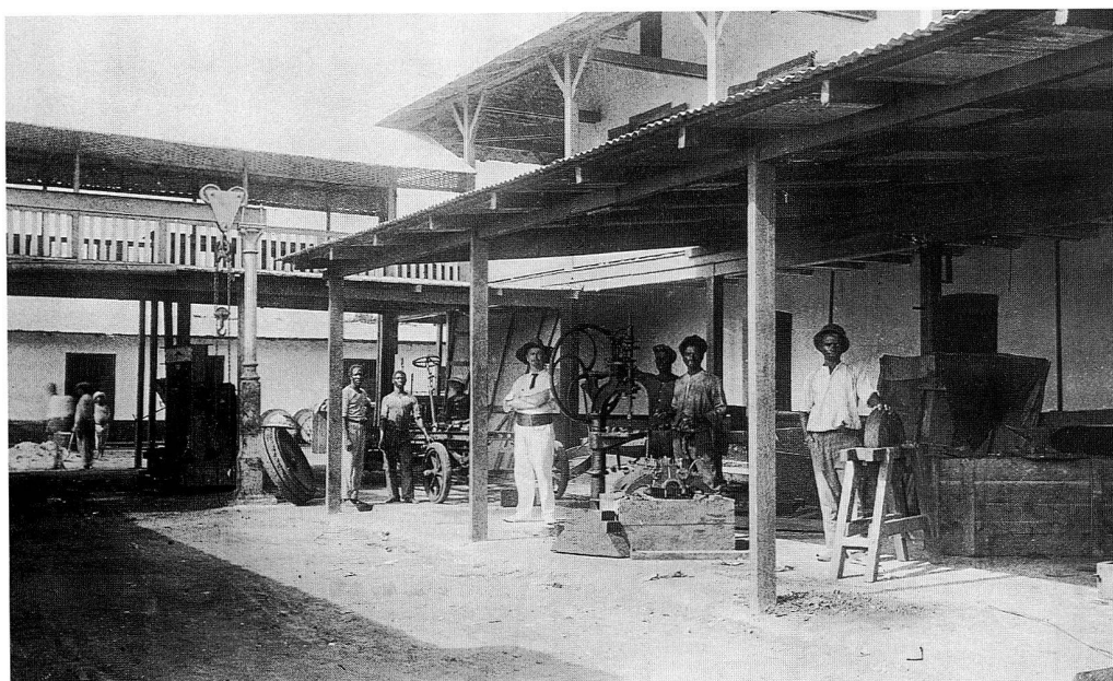
Abb. 9 (Sig. D-30.02.016) Copyright: Archiv der Basler Mission Noch handfest zeigte sich das Handwerk im Rahmen der Basler Mission nach der Einführung des Motorfahrzeuges in Ghana – hier die Anlage für Fahrzeugreparatur und -unterhalt auf dem Areal der Missions-Handels-Gesellschaft in Accra, Ghana, vor dem Ersten Weltkrieg.
