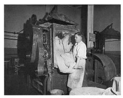
Vakuumkneter mit Flügelwellen in der Rheinischen Gummi- und Celluloidwaren-Fabrik um 1920; sie wurden u. a. in der Westdeutschen Celluloid-Fabrik Düsseldorf-Meerbusch bis 1984 eingesetzt. (Dokumentation 1984)
