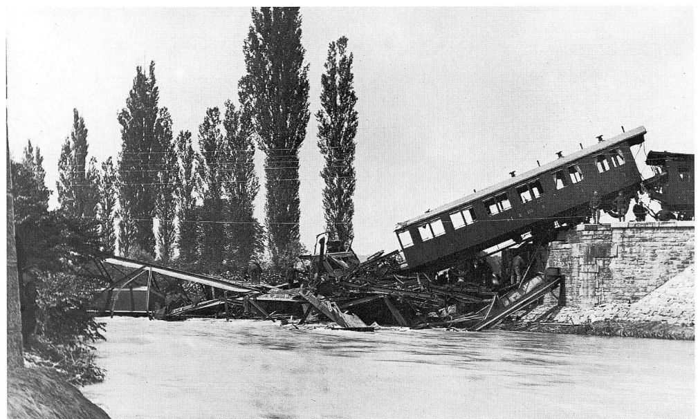
Die vordersten Wagen wurden mitsamt den Insassen in der eingestürzten Brücke zertrümmert und im Wasser der Birs überschwemmt: Fotografie der Katastrophenstelle um den 15. Juni 1891. Sammlung VHS Luzern.
