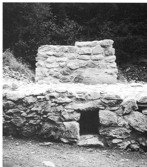
Bild 16: Offener Austritt des Luftkanals für den Essenzug
