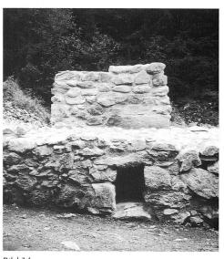
Bild 16: Offener Austritt des Luftkanals für den Essenzug
