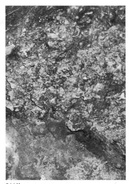
Bild II: Blei- und Bleioxidinfiltrationen im gesinterten Herdmaterial des Flammofens
