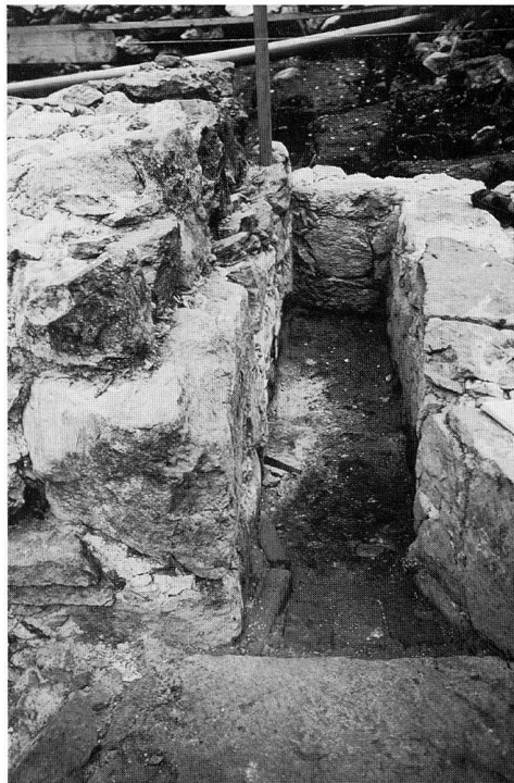
Bild 3: Feuerung und Aschefall nach der Ausgrabung 1992
