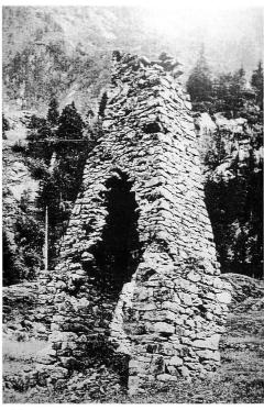
Bild 14: Esse des Trachsellauener Verhüttungsofens vor der Zerstörung durch die Stägen-Lawine 1931. Unterhalb des Sockels, von dem an sich die Esse nach oben verjüngt, befand sich die Flugstaubkammer.
