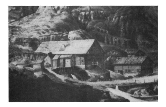
Bild 6: Bildausschnitt (aus Bild 5) Ofengebäude mit Wasserführung zur Radstube und aus dem Dach geführter Flammofenesse
