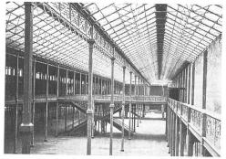
Fig. 8: Glasdach-Konstruktion von Francis Fowke, London 1862
