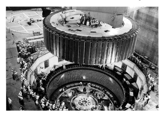
Montage des Rotors eines Wasserkraft-Generators der 700-MW-Klasse.
