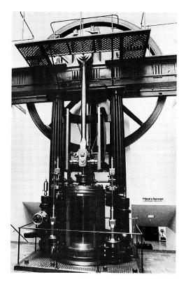
raschlaufender, sparsamer Dampfmaschinen. Zum vollständigen Ausgleich der hin- und hergehenden Massen sah er zwei gegenläufige Kolben pro Zylinder vor und übertrug dieses Prinzip sowohl auf stationäre Maschinen wie auch auf Schiffsmaschinen und Lokomotiven. In unserem Jahrhundert wurde das Doppelkolbenprinzip von Hugo Junkers bei Flugmotoren wieder aufgegriffen. Aber auch Sulzer und die britische Firma Napier wandten es verschiedentlich an. Bodmer seinerseits experimentierte mit während
