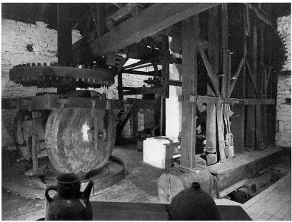
Bild 3: Olmühle in Lemgo-Brake. Bei dieser Mühlentechnik war nur der Lagerzapfen der Welle aus Eisen. Diese «hölzerne Maschine» produzierte bis 1925.
