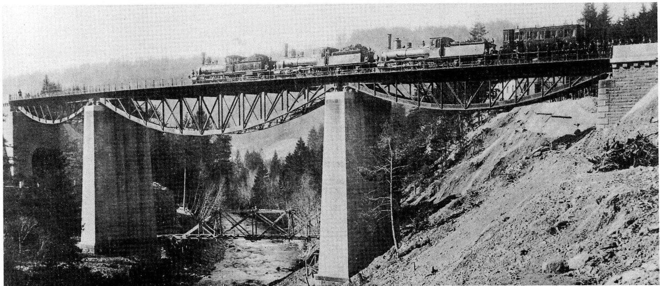
Wutachbrücke unter Belastungsprobe.
