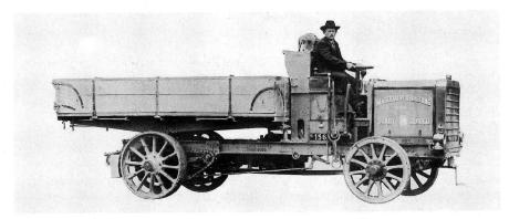
An dem Hercules-Lastwagen aus dem Jahre 1912 erkennt man vorne noch Holzspeichenräder mit Vollgummi- und hinten Georg Fischer Stahlguss-Speichenräder mit Eisenreifen zum besseren Antrieb. Die Bremsklötze wirkten von aussen direkt auf die Stahlreifen.
