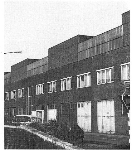
Bild 8: Westfassade der Vergütere, 1939/41.
