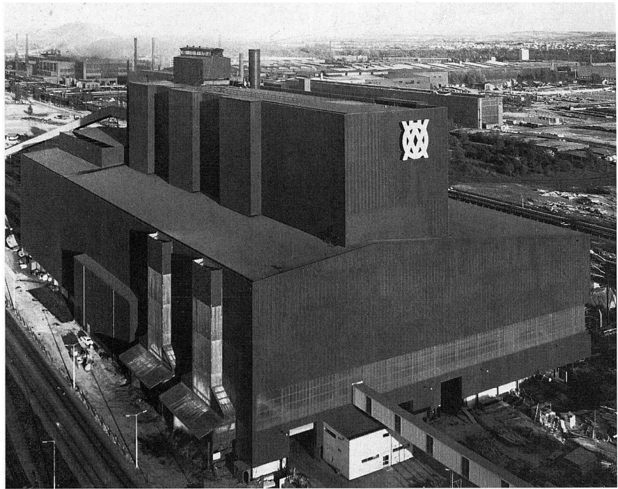
Bild 12: Das im Jahre 1973 vollendete LD-Stahlwerk III. (VOEST-ALPINE AG, Fotostelle.)
