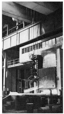
Gewaltige Schmiedeeinrichtungen: oben die Ofenanlage, unten die 2000-Tonnen-Presse und rechts der Manipulator vor der Schmiedepresse.
