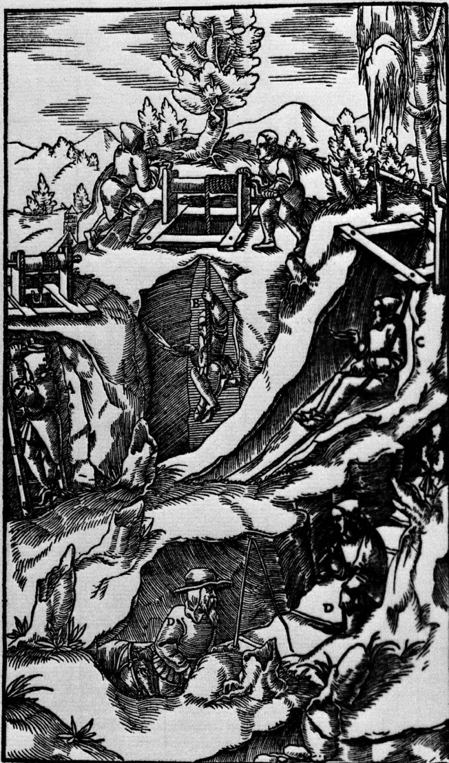
Ein Bergmann, der auf der Fahrt einführt A. 45) Einer, der auf dem Knebel sitzt B. Einer, der auf dem Leder einführt C. Auf Stufen, die im Gestein hergestellt sind, Einfahrende D. 45) Es ist zu beachten, daß der Einfahrende die Lampe auf der Kapuze befestigt hat.
