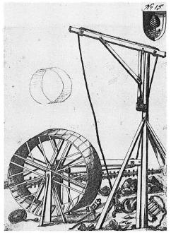
Entwurf eines Baukranes für den Augsburger Rathausbau.<sup>3</sup>
