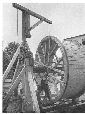
Nachbildung eines Baukranes für den Augsburger Rathausbau.<sup>6</sup>
