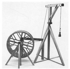
Modell eines Baukranes für den Augsburger Rathausbau.<sup>5</sup>
