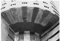
Bild 3: Turbowelle 1902 von Brown Boveri, 435 kW, 3000 U/min, Ballen 480 Ø×760 mm, Achswelle 125 mm Ø (Deutsches Museum München).
