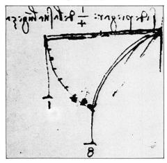
eine offenbar unter der Kraft 1, die andere unter der Kraft 8. Der Bogen, den das Stabende bei der Durchbiegung beschreibt, ist durch Pünktchen in acht Teile geteilt. Ich kann das nur so deuten, dass er zum Ausdruck bringen wollte, dass die achtfache Last den achtfachen Verformungsweg hervorruft, auch wenn er in der Eile auf dem Bogen ein Pünktchen zuviel gemacht hat, es hätten nur sieben Abschnitte sein dürfen. Trotzdem scheint mir, das Hooke'sche Gesetz war hier schon entdeckt!
