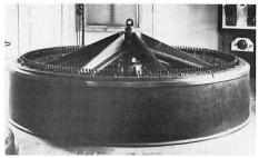
Bild 2: Erster vertikaler Drehstromgenerator vom Schirmtyp (1893)
