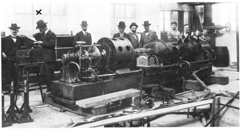
Bild 5: Die erste BBC-Dampfturbine Lizenz Parsons auf dem Prüfstand in Baden 1901. (x = C. E. L. Brown)
