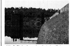
Abb. 2: Einlaufturm der römischen Talsperre Cornalvo bei Merida, Spanien. (Foto: G. Gabrecht.)
