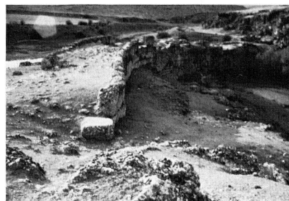
Abb. 1: Römische Talsperrenmauer von Aezani, Türkei.
