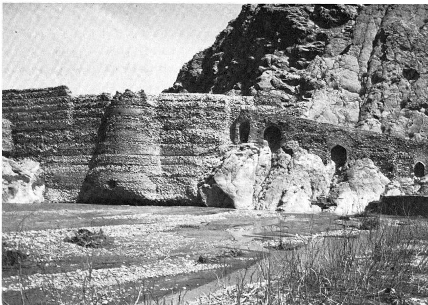
Abb. 3: Schwergewichtsmauer bei Saveh, Iran.
