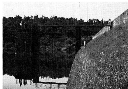
Abb. 2: Einlauffturm der römischen Talsperre Cornalvo bei Merida, Spanien. (Foto: G. Gabrecht.)
