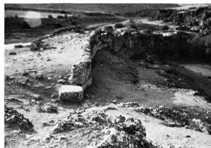
Abb. 1: Römische Talsperrenmauer von Aezani, Türkei.
