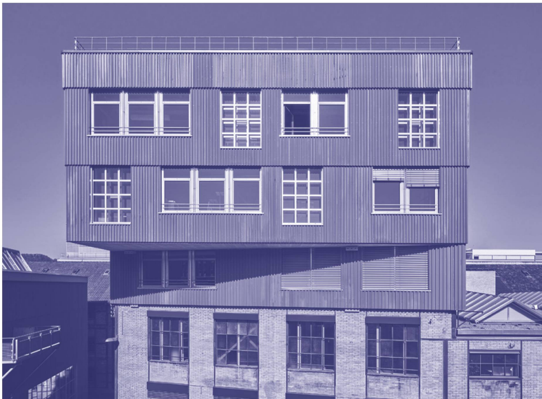
Kopfbau Halle 118, Winterthur. @baubüro in situ / Martin Zeller
