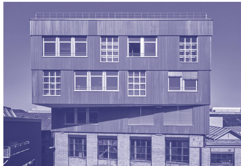
Kopfbau Halle 118, Winterthur. ©baubüro in situ / Martin Zeller
