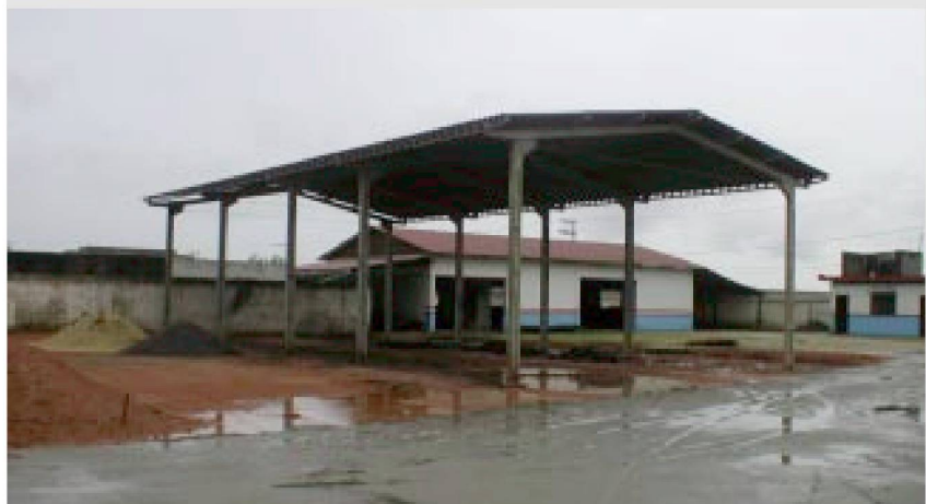
Die neu erstellte Halle im Rohbau
