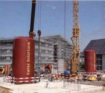
Die drei Mehrfamilienhäuser im Solarpark in Oberburg BE werden zu 100% mit Sonnenenergie für Heizung und Warmwasser versorgt. Mit grossen Wasserspeichern lässt sich Wärmeenergie mit Abstand am günstigsten speichern – vor allem auch saisonal.
