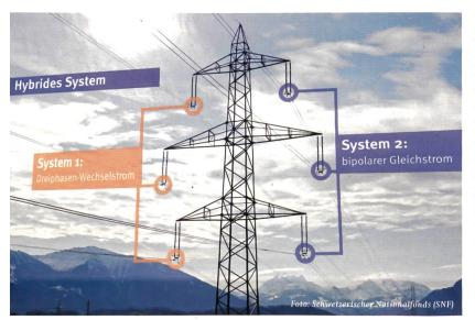
Das NFP70 will mit Lösungen zur Energiewende beitragen und forscht z.B. zum Potenzial hybrider Freileitungen und Stromspeicher der Zukunft.
