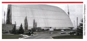
mp. Im Dunst der verlassenen Stadt Prypjat wächst der neue Sarkophag, der die Ruine des explodierten Reaktors 4 einschliessen soll. Der Bau kommt nur stockend voran. Doch die Zeit drängt: Der alte Sarkophag, der kurz nach dem GAU im Eiltempo gebaut wurde, ist brüchig. Bricht die notdürftig gestützte Konstruktion ein, tritt erneut radioaktive Strahlung aus. Auch der neue Einschluss ist nur eine Lösung auf Zeit: Halten soll er die nächsten 100 Jahre. Und dann?
