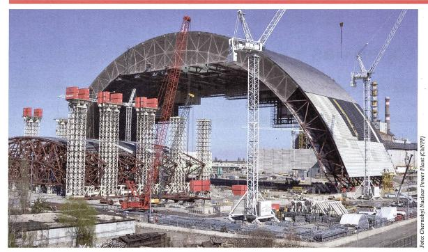
Noch lange eine Atom-Ruine und ein riesiges Bauwerk: 257 Meter breit, 164 Meter lang, 110 Meter hoch und 29'000 Tonnen schwer wird der neue Sarkophag nach der Fertigstellung sein. Er soll für 100 Jahre den zerstörten Reaktor sicher einschliessen.
