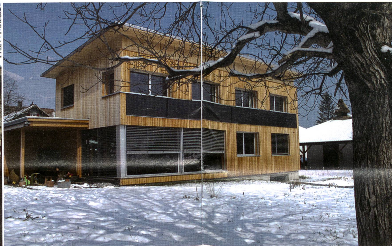
Während eines kalten Winters braucht das energieeffiziente Haus für Heizung und Warmwasser zirka 8 Ster Holz. Die Stücke sind 1 m lang (links). Das neue Haus der Bergführerfamilie Zimmermann mit 14 m² Solarkollektoren an der Fassade und 90 m² Photovoltaik auf dem Dach (rechts).
