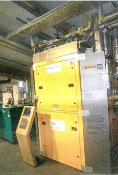
Jüngstes Beispiel für die ideale Kombination von Photovoltaik und Wärme-Kraft-Kopplung ist die Umweltarena in Spreitenbach von Kompogas-Erfinder Walter Schmid: Das Block-Heiz-Kraftwerk (BHKW) der Umweltarena nützt das Biogas der eigenen Kompogasanlage zur Strom- und Wärmeversorgung.
