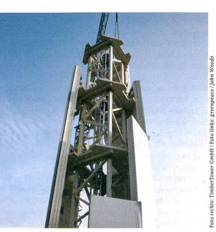
Foto links: Erdölabbau aus Ölsand. Erdöl muss aus immer schwerer zugänglichen Quellen mit immer grösserem Energieeinsatz gefördert werden. Foto rechts: Türme für Windkraftanlagen aus Holz statt Stahl sind eine Möglichkeit, den Anteil nicht erneuerbarer Primärenergie zu verringern.
