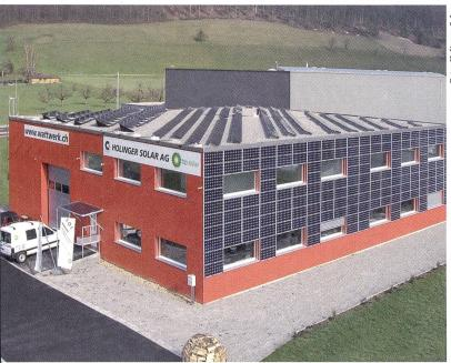
Energieeffizienz pur: Das Wattwerk in Bubendorf BL ist das erste Plus-Energie-Gewerbehaus der Welt. Es liefert mehr Energie als für den Betrieb verbraucht werden.
