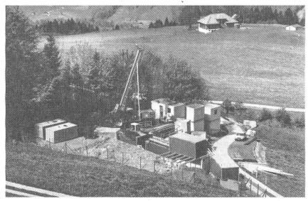
"Die Nagra hat auf Schwandrain am Wellenberg (NW) vom 15. Mai bis 24. August 1990 ihre erste Sondierbihrung mit der Bezeichnung SB 4 abgeteuft. Die Bohrung wird - wie üblich bei Sondierbohrungen der Nagra - durchgehend gekernt." Keystone-Bildlegende.
