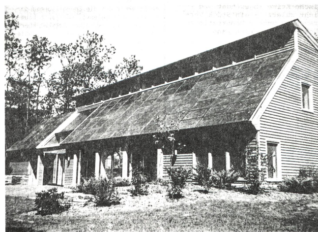
Neben öffentlich geförderten Solarhäusern zu Testzwecken, wie diesem hier, werden heute auch schon private Wohnhäuser mit Solarstromversorgung gebaut. Im US-Staat Colorado ist der Sonnengenerator auf dem eigenen Dach schon bei einer Entfernung von 400 m vom öffentlichen Netz rentabel.
