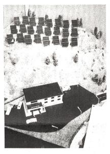
Modell der 45-kW-Demonstrationsanlage auf der italienischen Insel Giglio zur Versorgung eines Kühlhauses. bereitung und Entsalzung, Eisherstellung für ein landwirtschaftliches Kühlhaus, Versorgung einer Fernsehstation, Konstrolleinrichtungen auf einem Flugplatz, Wasserstoffherstellung für eine Halbleiterfabrik.
