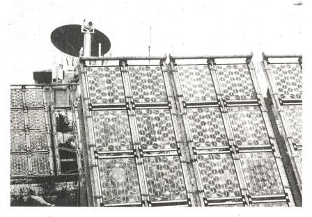
In einigen Jahren werden Solarzellen für die alltägliche Stromversorgung mit herkömmlichen Grosskraftwerken konkurrieren können. Heute werden sie erst für Spezialzwecke verwendet wie hier in der Versuchsstation "La Turbie" oberhalb von Monte Carlo für Fernmeldeanlagen.
