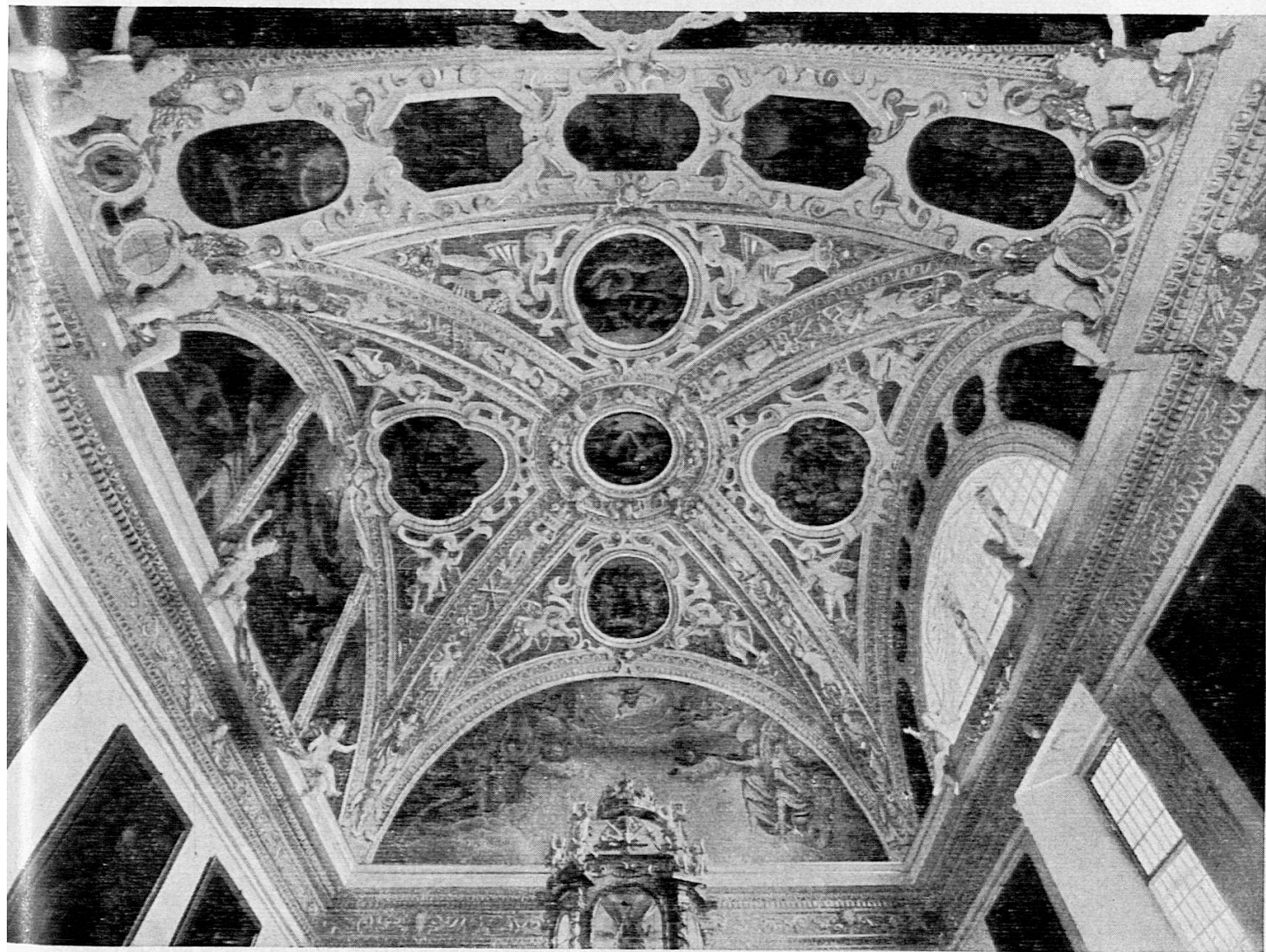
Santa Maria Calanca: L'interno con lo stupendo soffitto a cassettoni.
