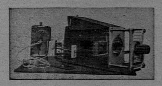
APPARECCHIO "ISTITUTO II." per proiezione, in locali oscurati, sino a 20 metri ed in locali semi oscurati sino a 40 metri con evidenti vantaggi per il mantenimento della disciplina, minore spesa per oscuramento, ecc. E' munito di passavedute formato 8 1 12 x 10;
