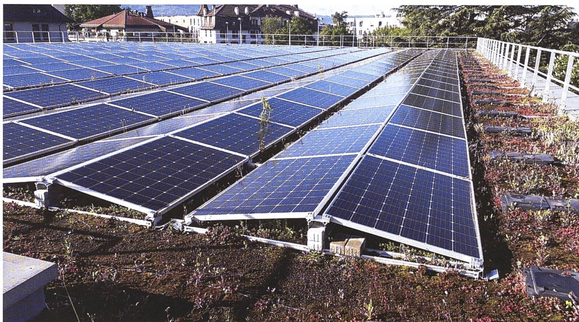
Fig. 2. Illustration de la toiture végétalisée photovoltaïque de la salle Omnisport du Petit-Lancy. (Photo Julie Steffen)
