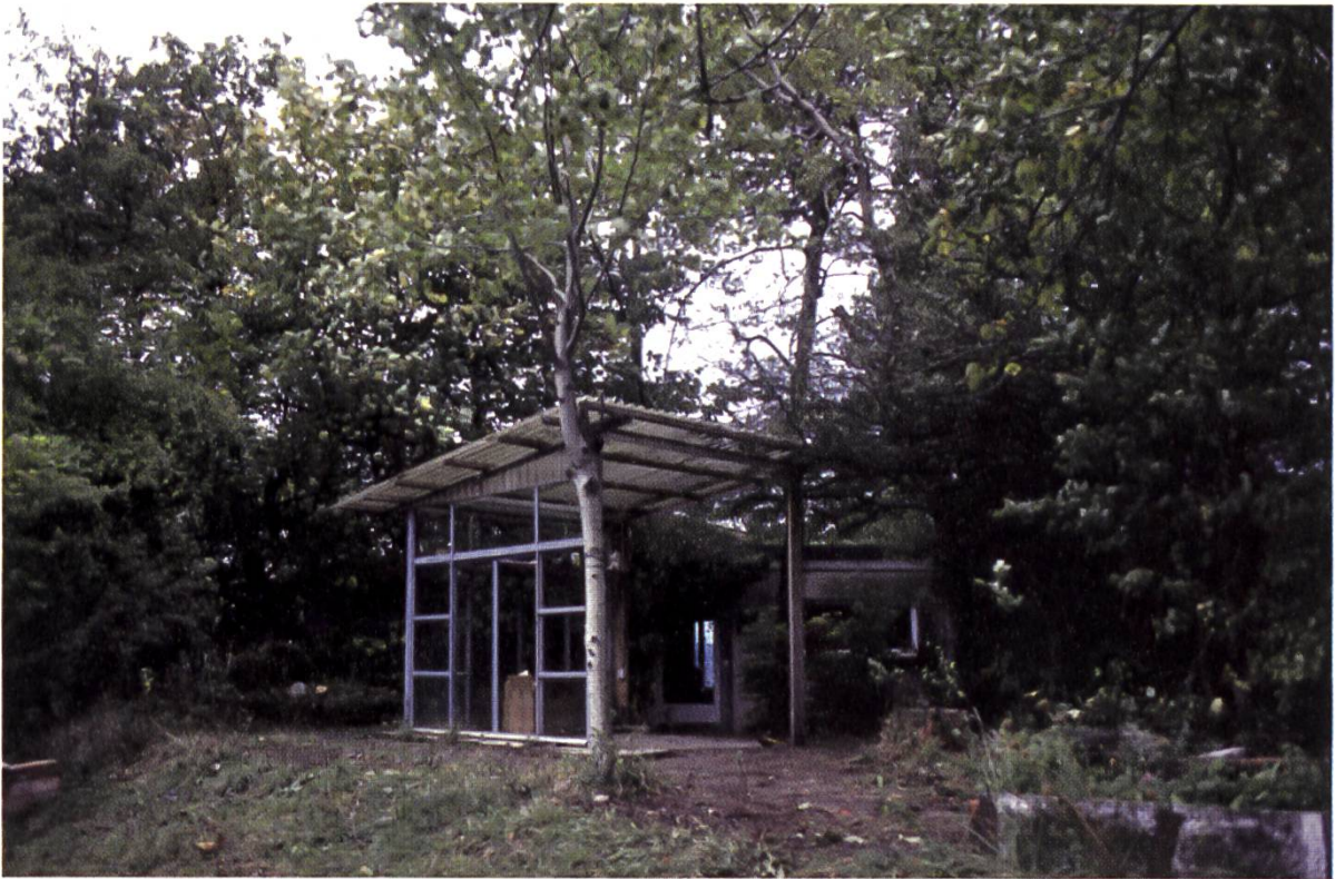
Lichtfanganlage von Hans Bachmann im Bergli (Ober Zeihen/AG) 1993, kurz vor dem Abbruch der Anlagen (Foto W. Huber).
