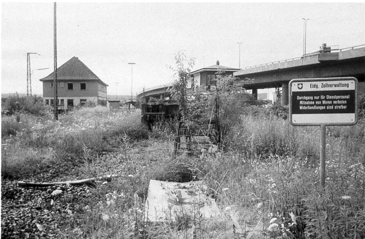
Abb. 3. Verlassene Stellwerkhäuser bei Fangstation 1.1 (Abb. 1) im Badischen Rangierbahnhof, aufgenommen von deutschem Boden aus am 16.7.1995.
