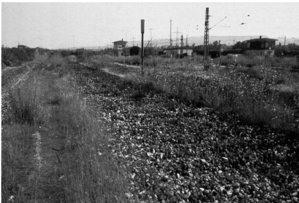
Abb. 4. Basel-Kleinhüningen, Westrand des ehemaligen Badischen Rangierbahnhofs nahe der Landesgrenze, Blick in Richtung Norden gegen Weil am Rhein (Baden-Württemberg). Streifen von groben Schotterkörpern im Bereich rückgebauter Geleise wechseln mit feineren, kiesig-sandigen Streifen in den Zwischenräumen ab. Aufnahme : A. Coray, 4. Aug. 1993, ca. 10.30 Uhr.
