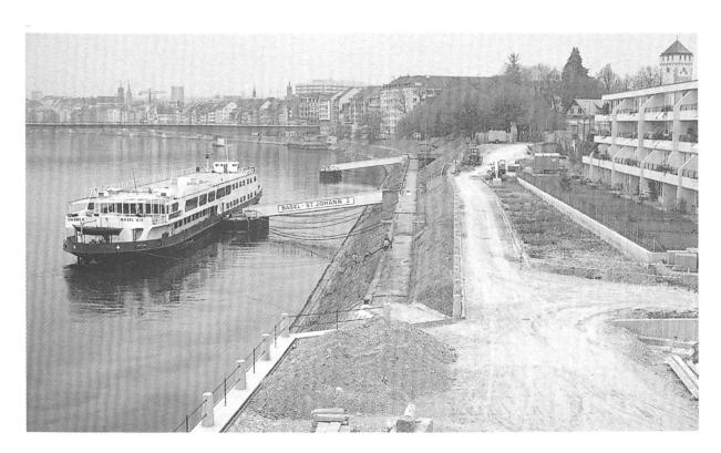
Abb. 11. Das Rheinbord St. Johann von der Terrasse des Restaurants "Rhypark" aus. Unten die Rohanlage der Piazza, dahinter die noch belagslose Rheinpromenade. Zwischen Rheinpromenade und Bermenweg die steile Grasböschung mit umgelagerten Rasenteilen neben den Granitpfosten im Mittelgrund und neu humusierten Flächen weiter vorne. Rechts neben der Promenade die frisch ausgehobenen Gruben für die zu pflanzenden Junglinden. 12.XII.1987 (35mm-Weitwinkelaufnahme A. CORAY).
