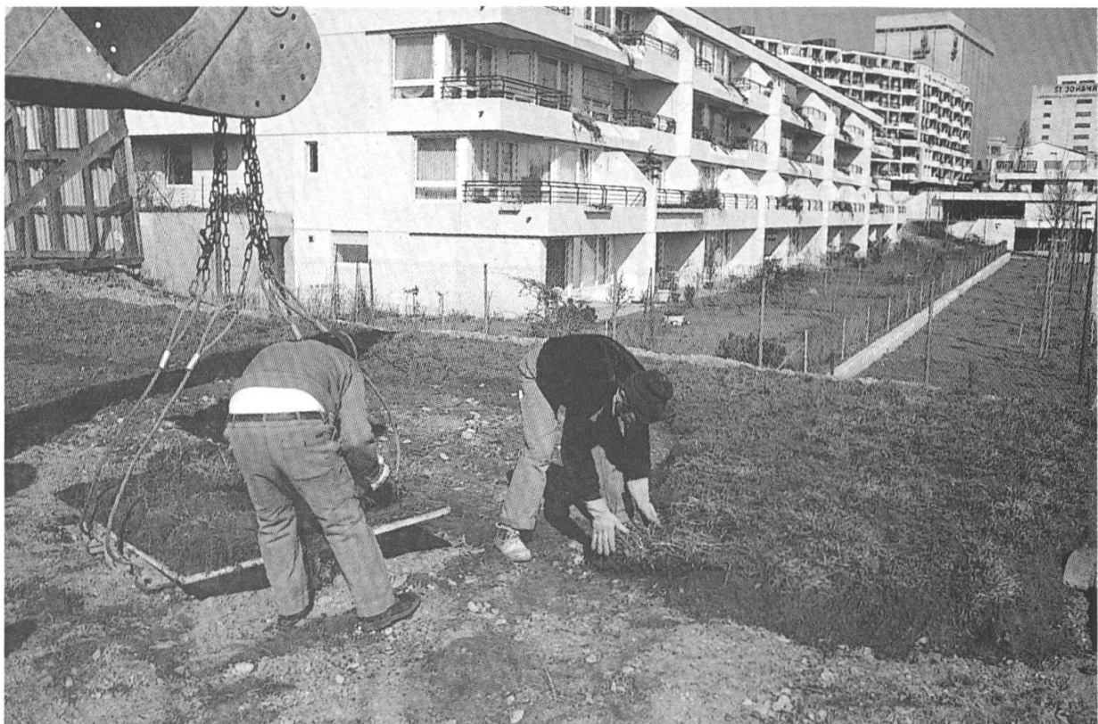
Abb. 14. Zusammenfügen der Rasenteile im Zwischenlager. 9.III.1989 (Foto A. CORAY).
