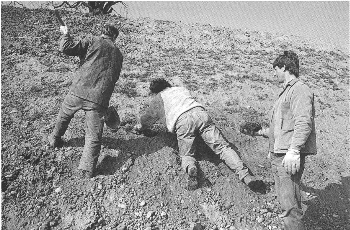
Abb. 15. Rückversetzen von Rasenziegeln in die vorbereitete Böschung im Bereich der abgerissenen alten Schiffsstation durch eine Equipe der Gartenbaufirma Jos.Schneider AG. 16.III.1990 (Foto A. CORAY).
