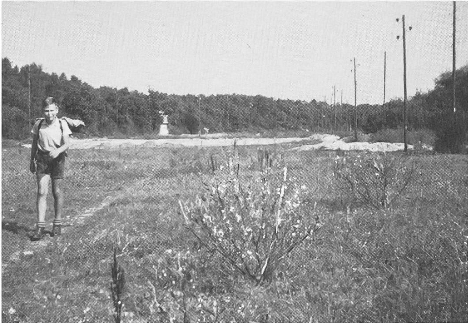
Abb. 4: Bauschutt und Erd-Depots für Baum-Gärtnerei (13. 9. 59)
